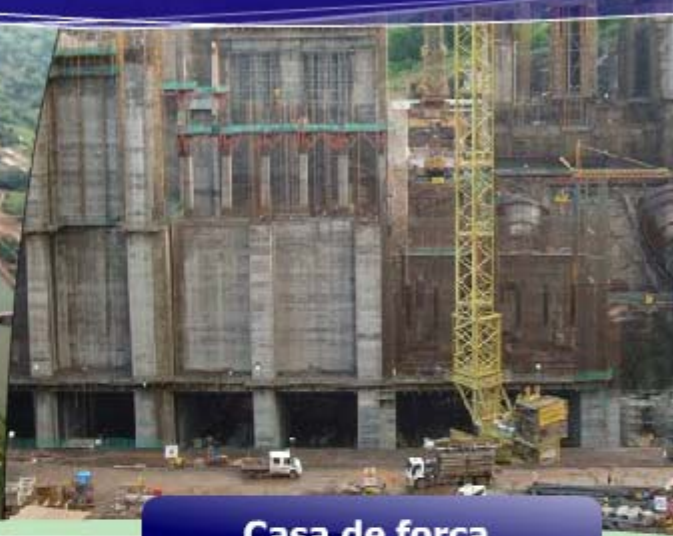
Casa de força
