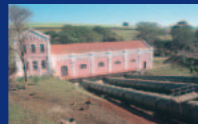
PCH São Joaquim | conduto forçado e casa de força São Joaquim SHP | enforced and power house
