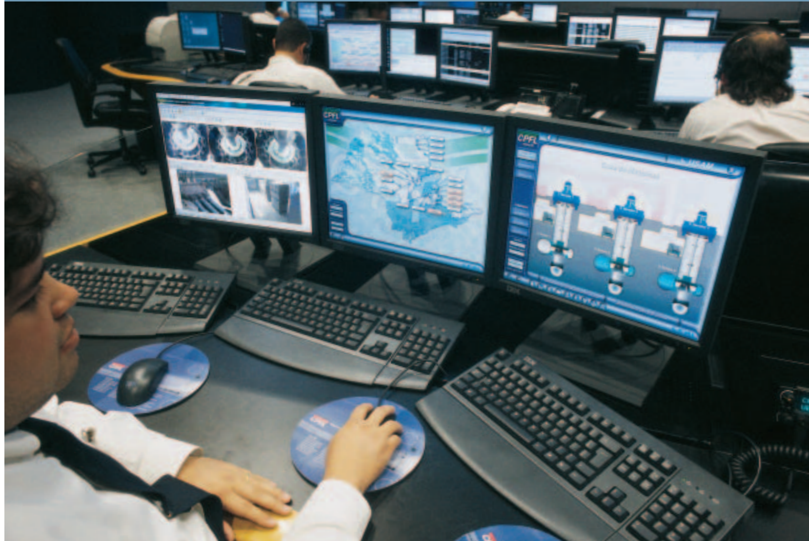
COG - Centro de Operações da Geração | Sede da CPFL COG - Geração Operation Center | CPFL headquarters
