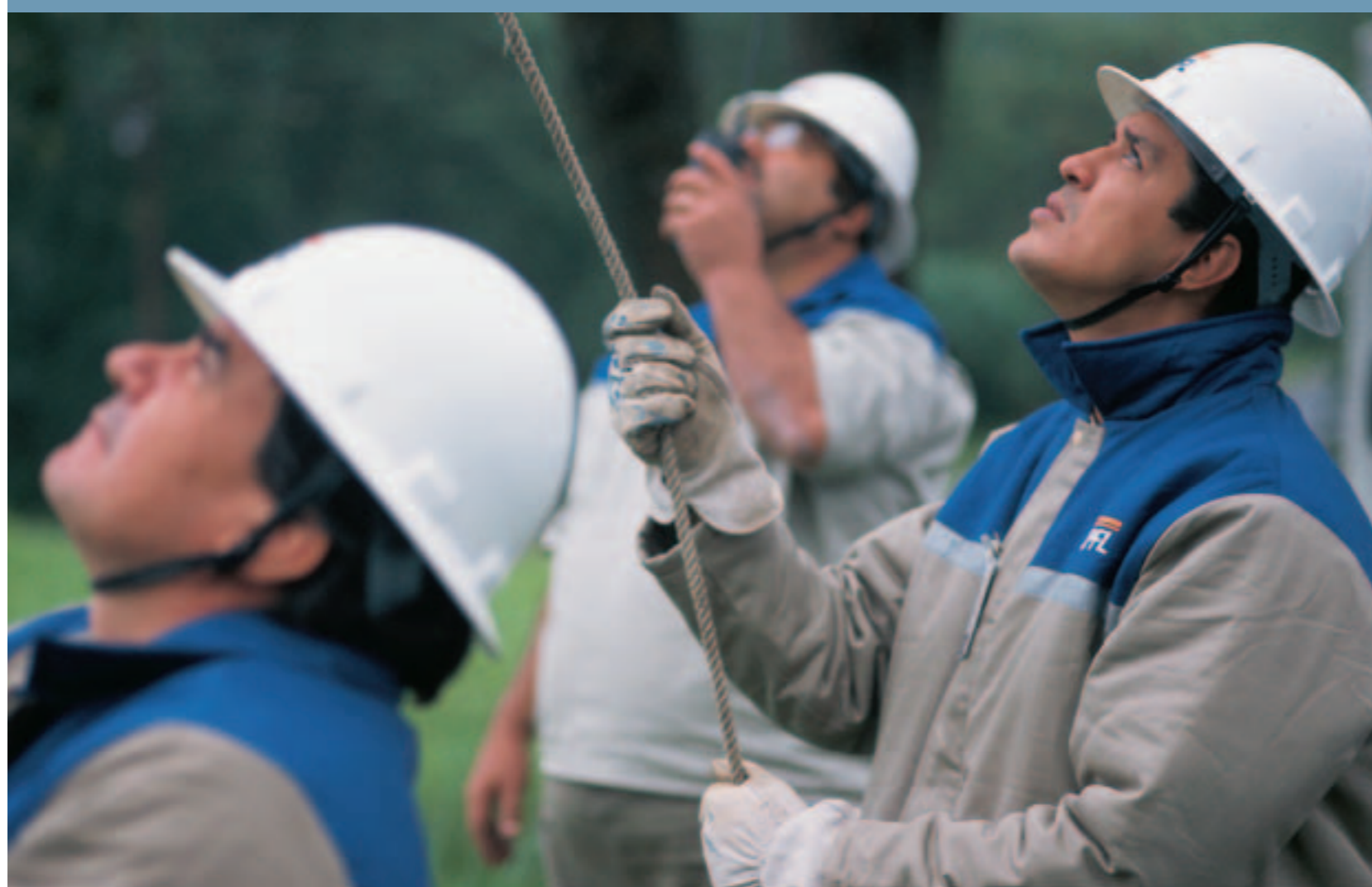
Eletricistas | Manutenção em linha de transmissão Electrician | Maintenance on transmission line
