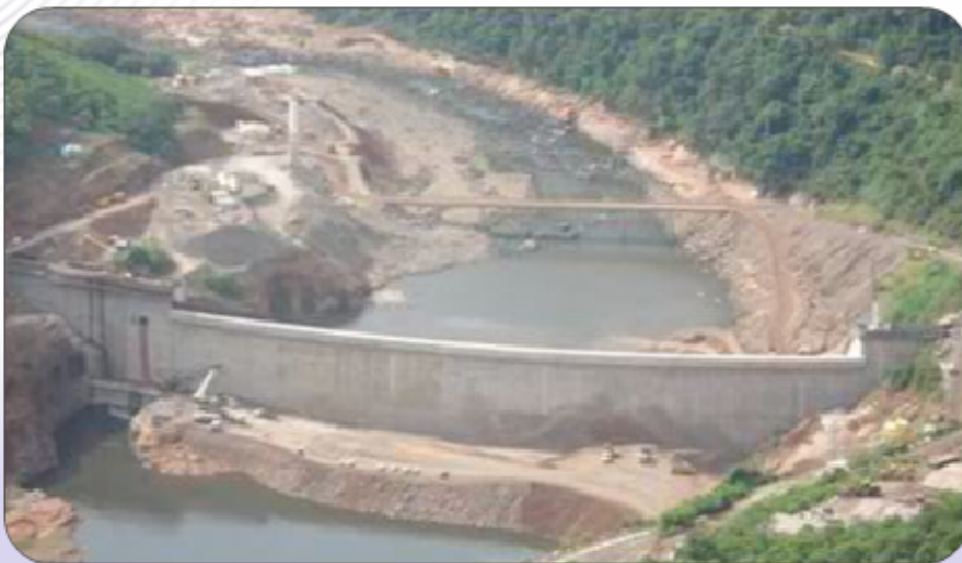
Situação: 15/01/08 (antes do enchimento)
