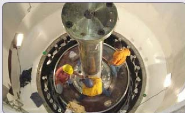
Casa de Força
