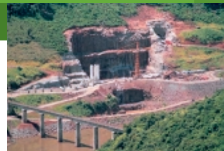
UHE Monte Claro / RS - Estágio atual das obras Monte Claro hydroelectric power plant - under construction
