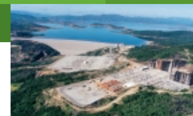
Usina Hidrelétrica Serra da Mesa - GO Serra da Mesa (state of Goiás) Hydroelectric Power plant
