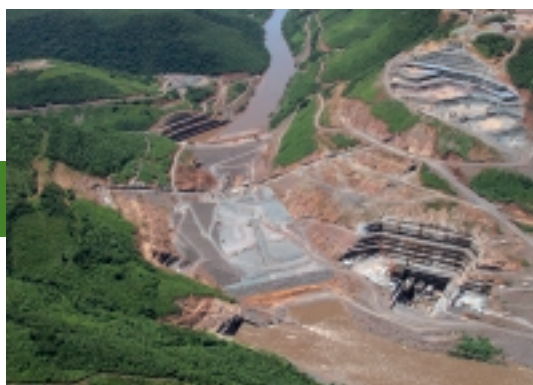
UHE Barra Grande / SC - Estágio atual das obras Barra Grande hydroelectric power plant - under construction
