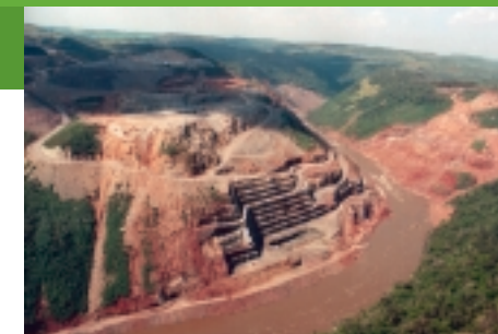
UHE Campos Novos / SC - Estágio atual das obras Campos Novos hydroelectric power plant - under construction
