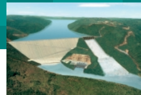
UHE Barra Grande | SC/RS | Visão após construção Barra Grande Hydroelectric Power Plant | States of Santa Catarina and Rio Grande do Sul | View after construction
