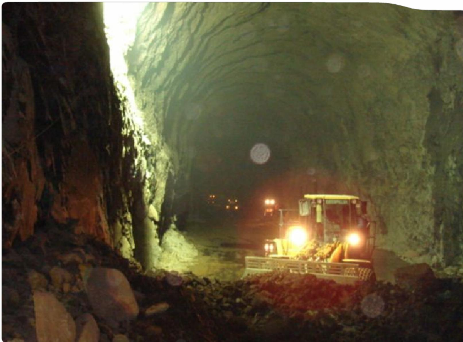
Vista interna do TD1 – remoção do tampão definitivo em concreto
