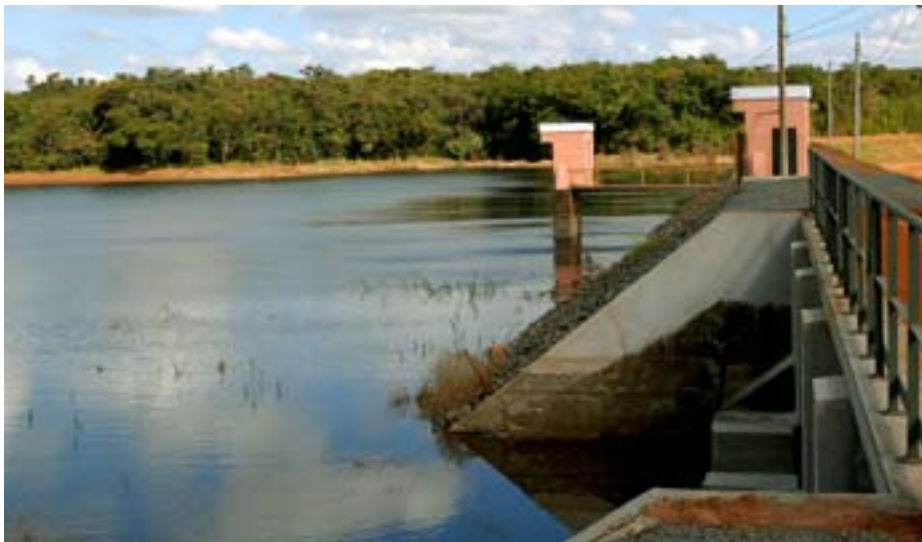
PCH Capão Preto
