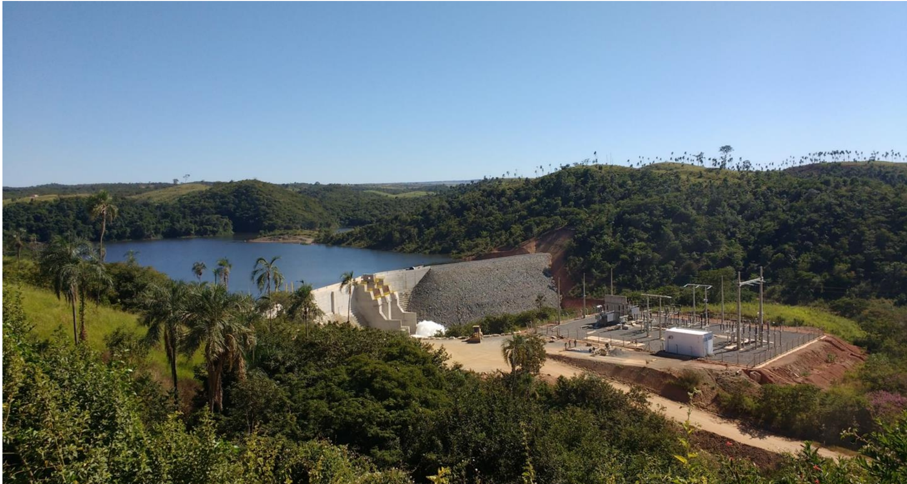
Vista geral (subestação e reservatório)
