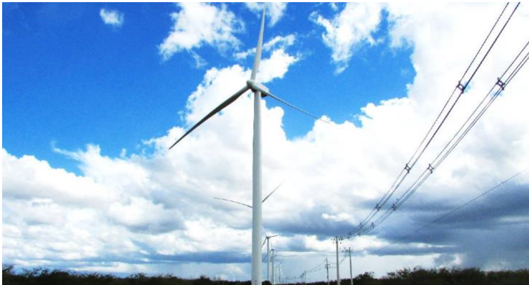
Vista de aerogeradores
