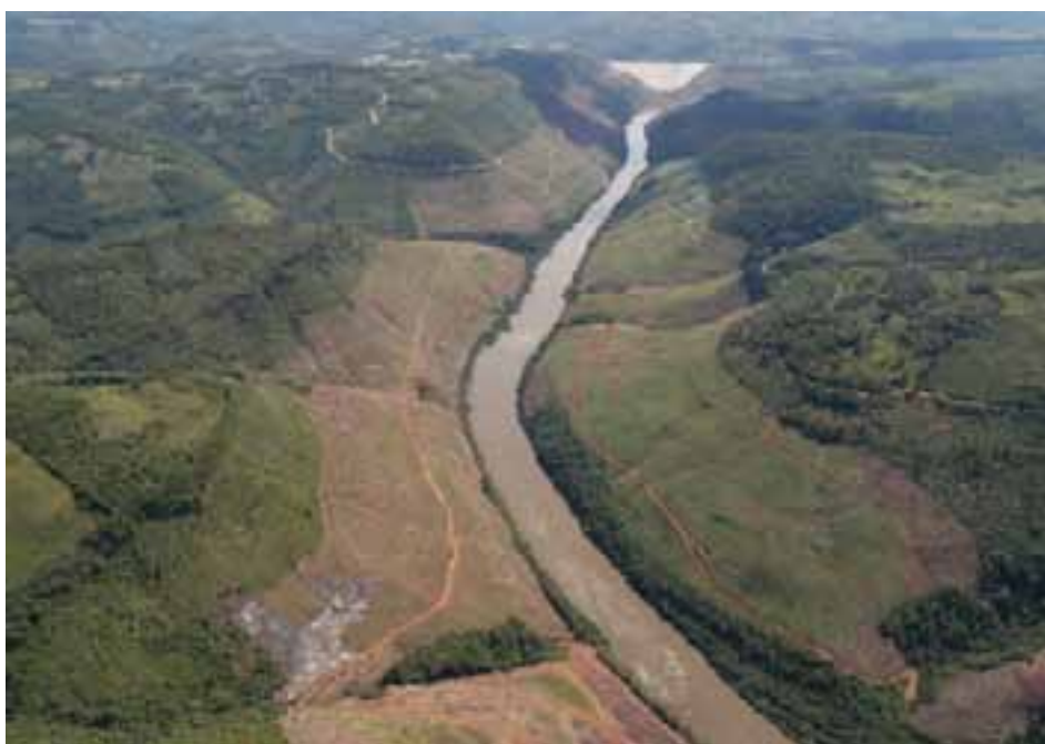
Vista geral da região do futuro reservatório | UHE Barra Grande | Santa Catarina e Rio Grande do Sul
