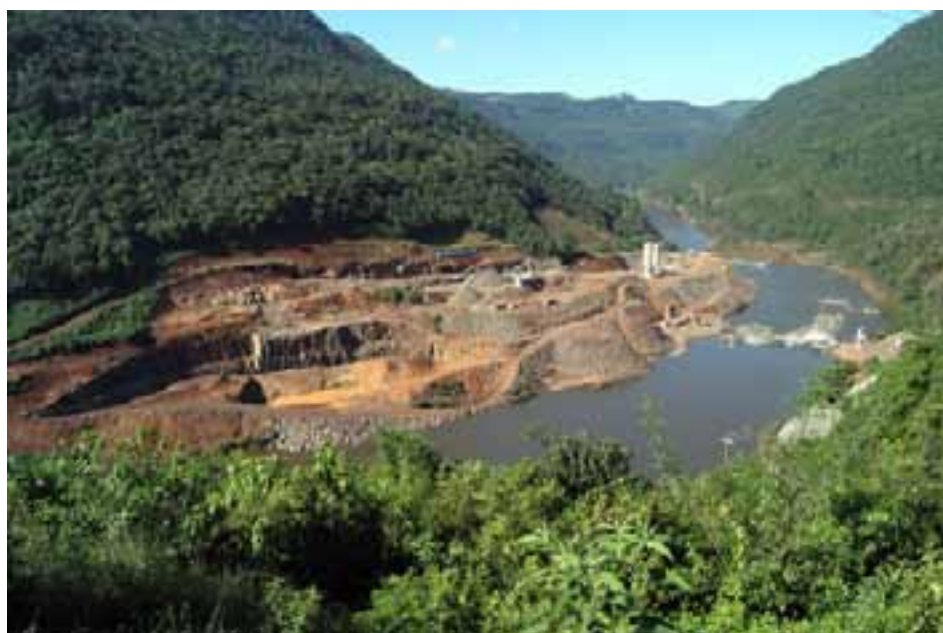
Vista geral das obras na região da barragem | UHE Castro Alves | Rio Grande do Sul
