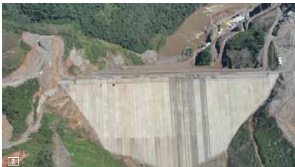
2 – Vista da laje de montante da barragem | UHE Campos Novos | Santa Catarina
