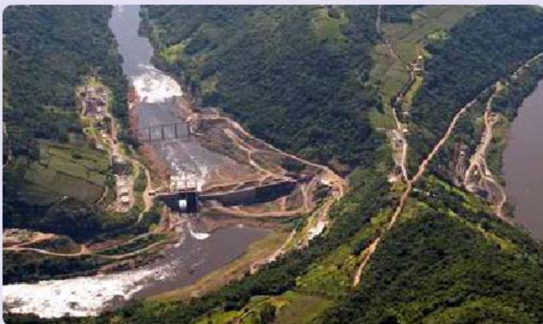
UHE 14 de Julho
