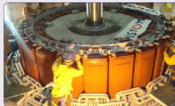
Casa de Força
