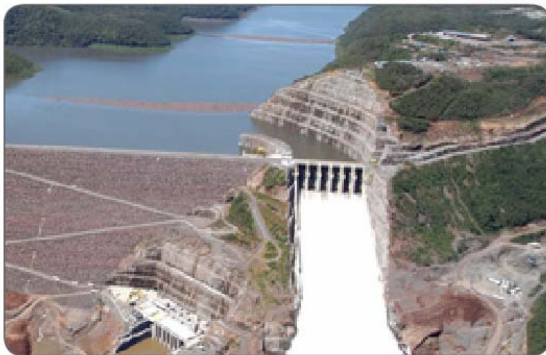
Vista geral da barragem
