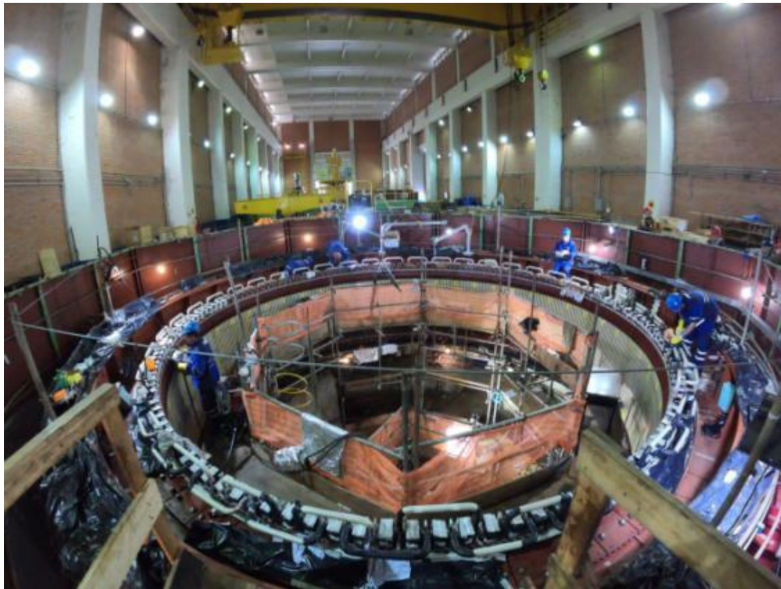
REVITALIZAÇÃO DO UNIDADE GERADORA 2 - UHE PASSO REAL - 2018
