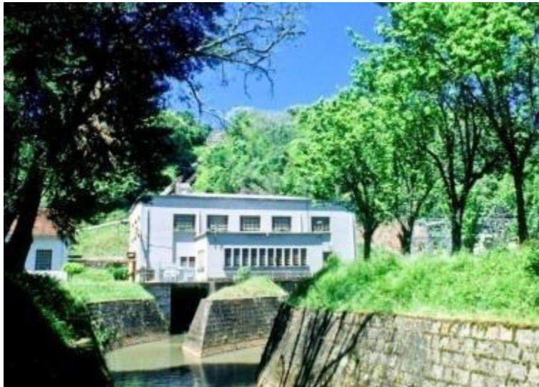
PCH Capigui – 3,76 MW de potência instalada
