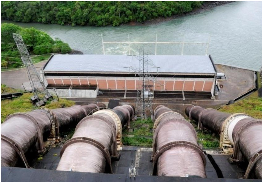
UHE Itaúba | 500 MW | Rio Jacuí
