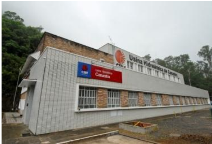
UHE Canastra - 42,5 MW de potência instalada
