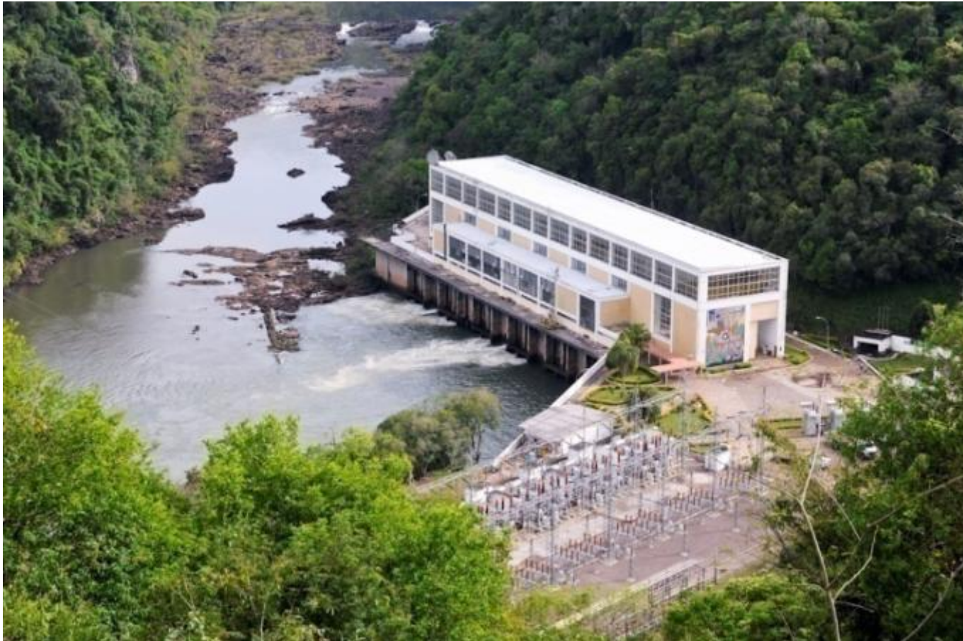
UHE Jacuí - 180 MW de potência instalada
