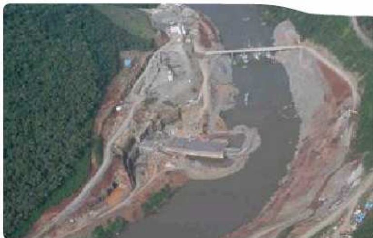
UHE Castro Alves - Vista da região da Barragem
