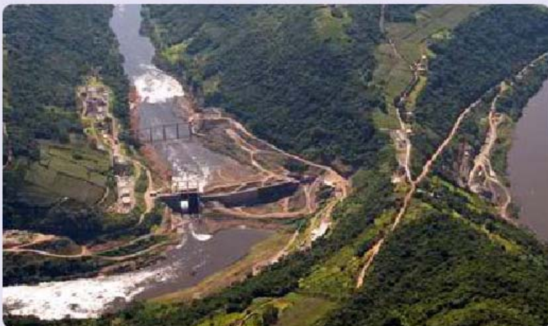
UHE 14 de Julho
