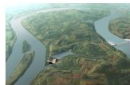
Foz do Chapecó – Visão após construção
