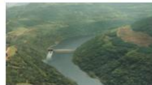
Monte Claro – Visão após construção
