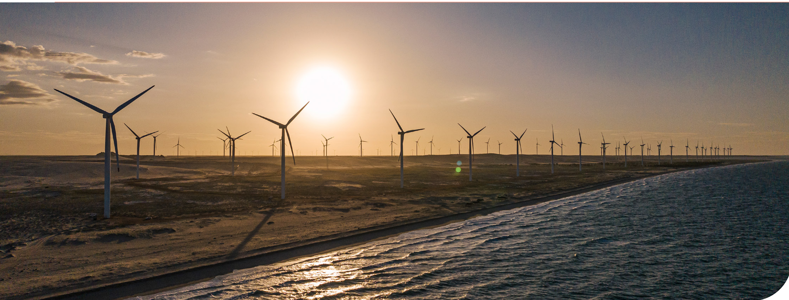
Complexo Eólico de Aracati, no Ceará.
