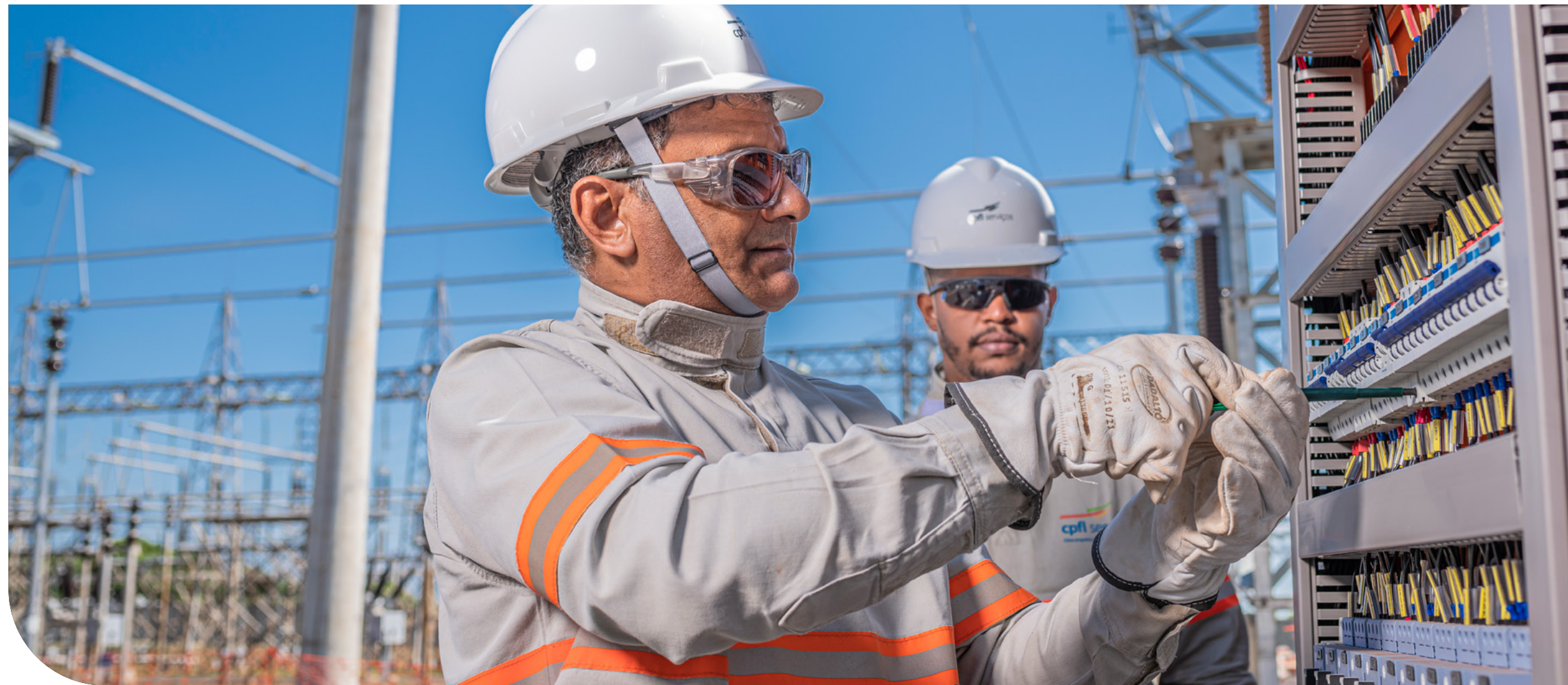
Operação da CPFL Soluções em São Carlos (SP).
