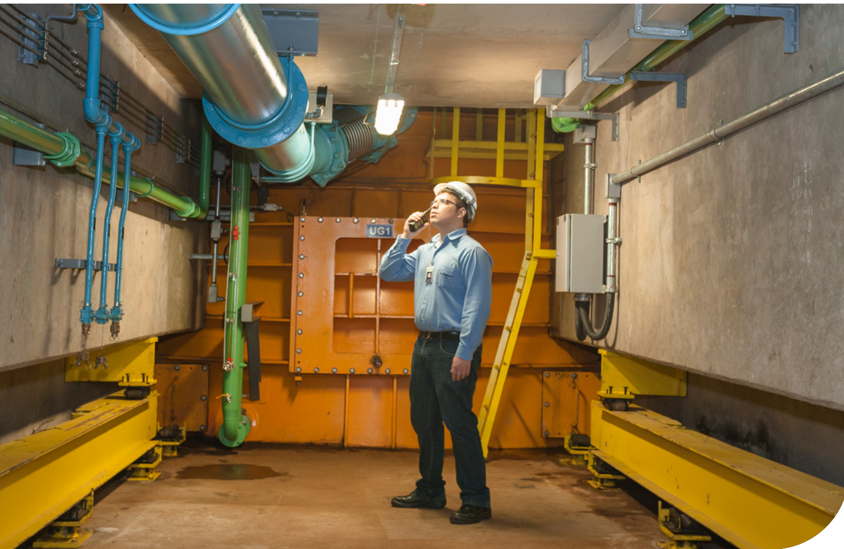
Colaborador na UHE Foz do Chapecó, em Santa Catarina.
