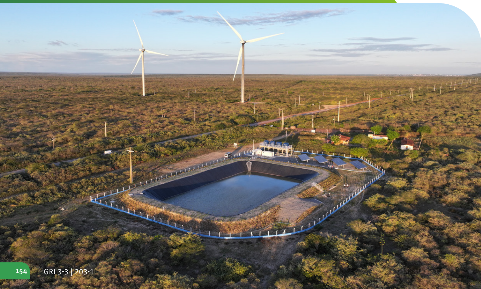
Planta de dessalinização de água construída no interior do Rio Grande do Norte.
