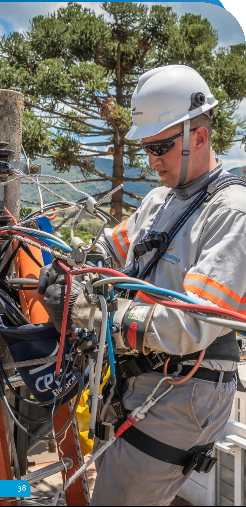
Manutenção em rede da CPFL Piratininga (SP).
