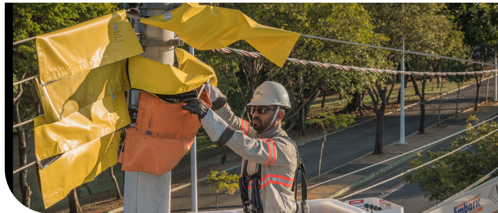
Manutenção em rede da CPFL Piratininga (SP).
