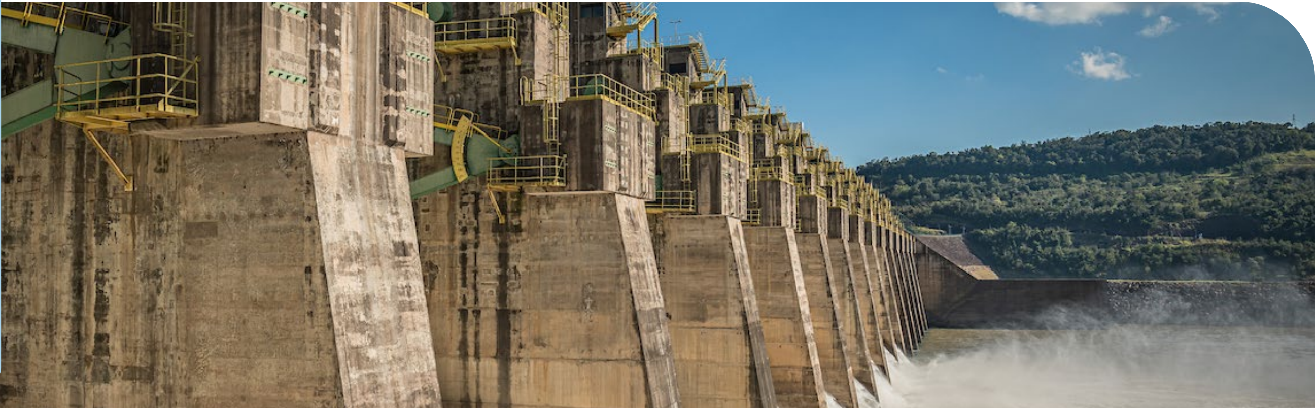
UHE Foz do Chapecó, em Santa Catarina (SC)
