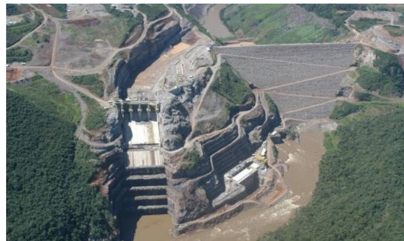
Campos novos – Vista geral da jusante da obra
