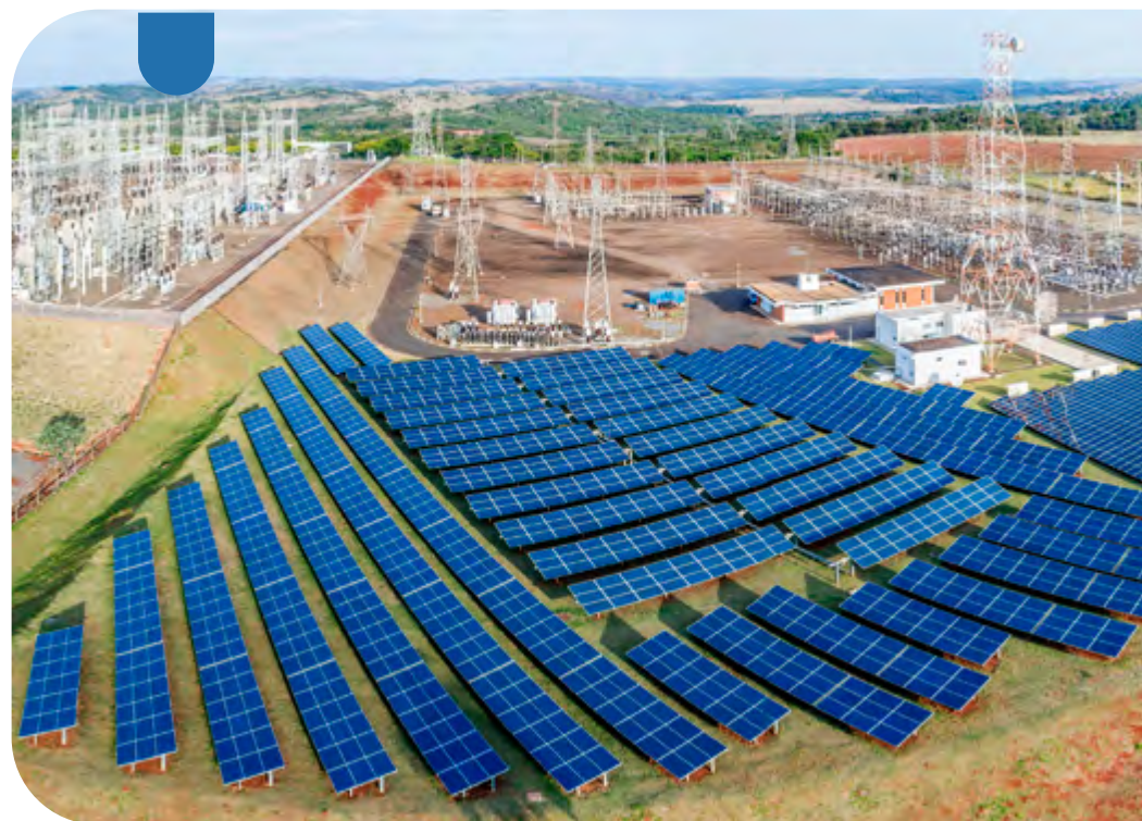
Subestação e Usina Solar de Tanquinho em Campinas - SP
