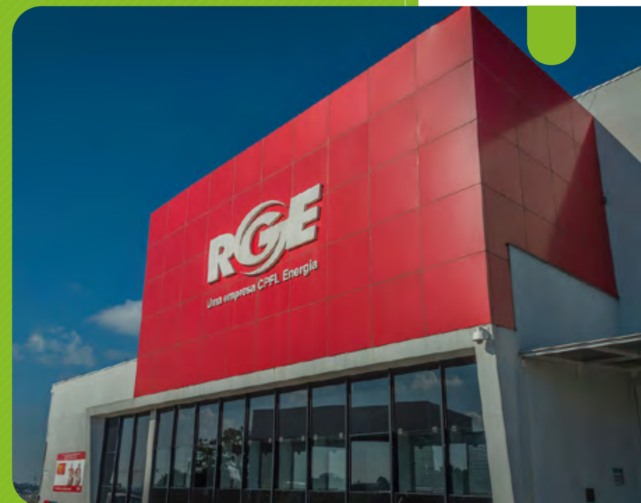
Estação Avançada da RGE em Caxias do Sul - RS
