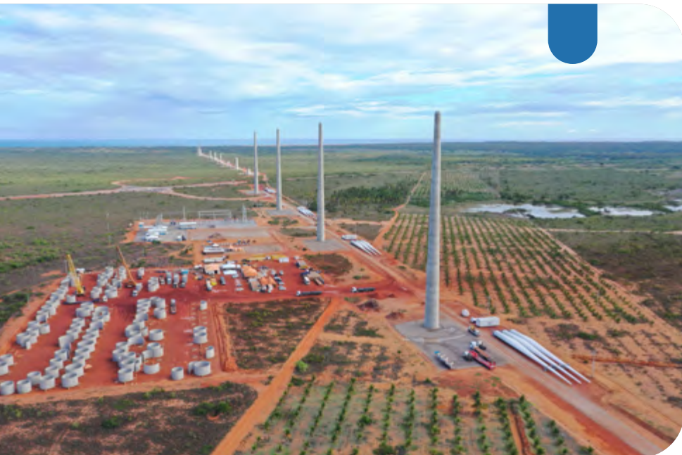
Construção do Complexo Eólico Gameleira - RN
