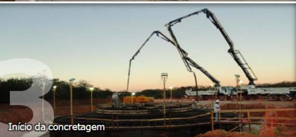
Concreto de regularização da laje de subpressão
