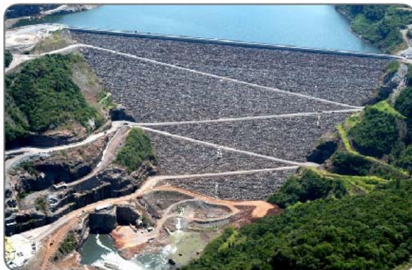
Vista geral da barragem
