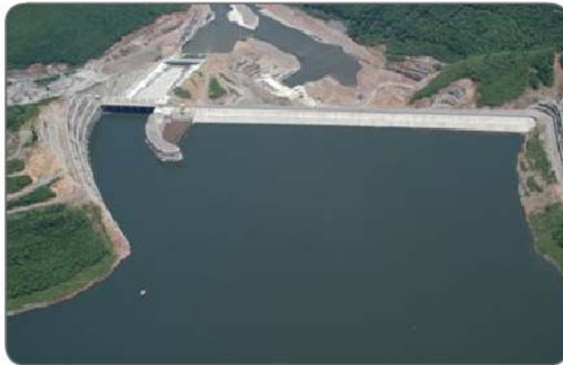
Vista geral da barragem
